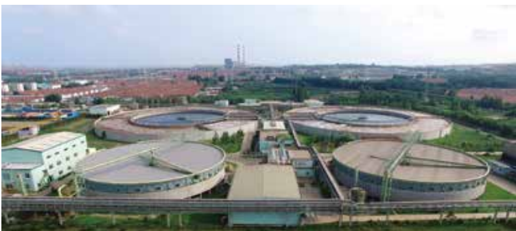
山东公司为污水处理场加盖，以减少异味排放
