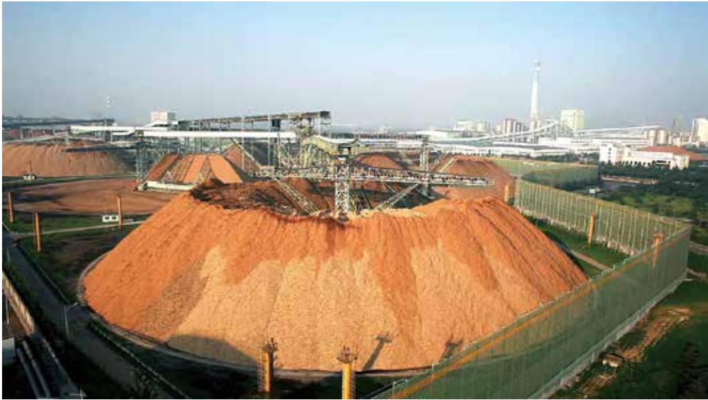
山东公司的木片原料堆场
