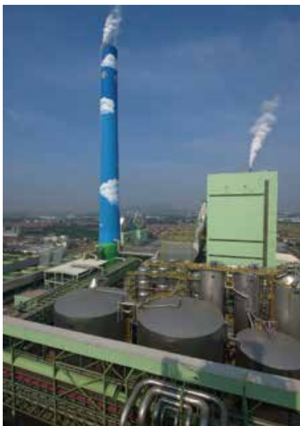
山东公司碱回收系统全景
